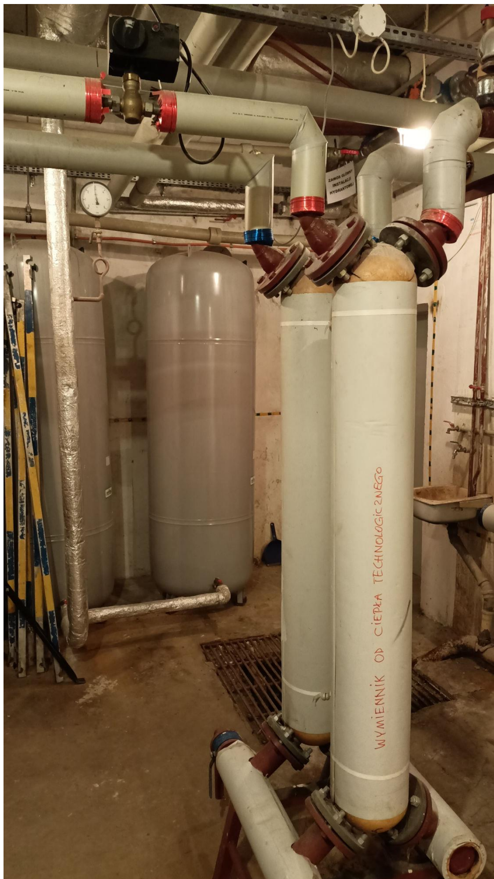
Rys. 1.1 Instalacja ciepła technologicznego - zasilenie.
