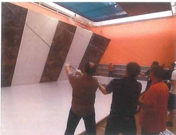
Il. 2. Prace konserwatorskie w l. 2010-12
