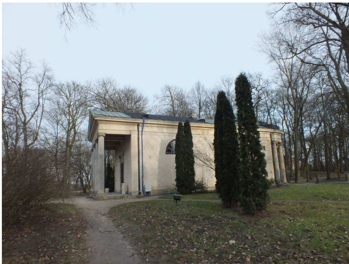
Fot.19 Elewacja północno - zachodnia.
