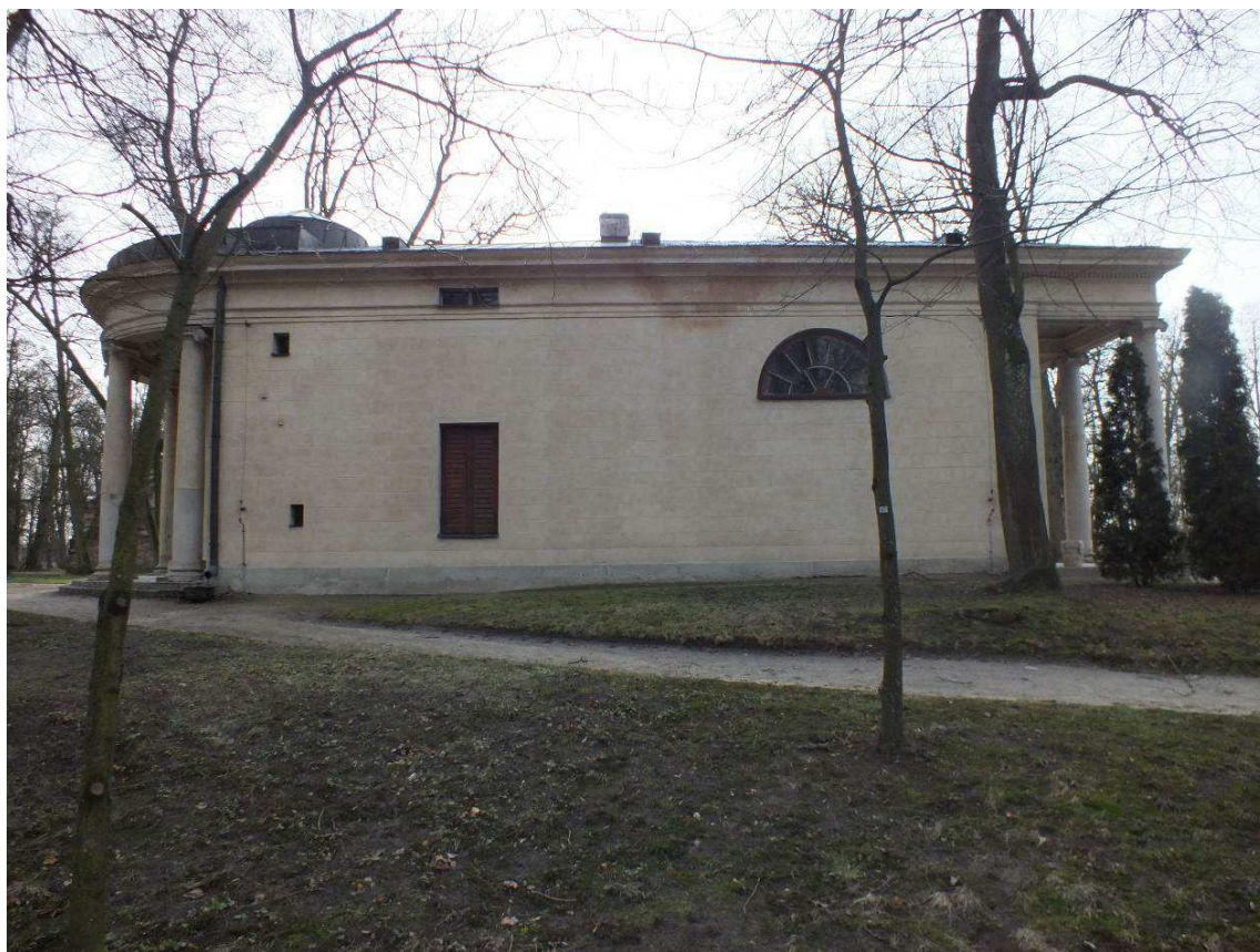
Fot.21 Elewacja południowo - wschodnia.
