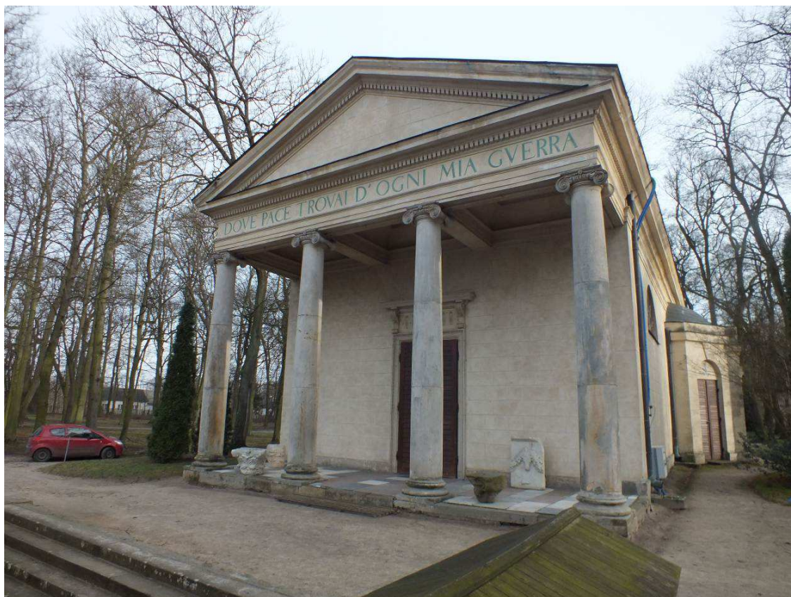
Fot.18 Elewacja frontowa – północno – zachodnia.
