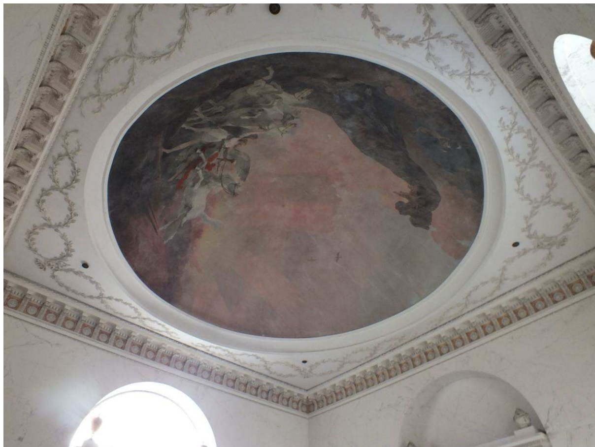
Fot.36 Widok na konstrukcję plafonu.
