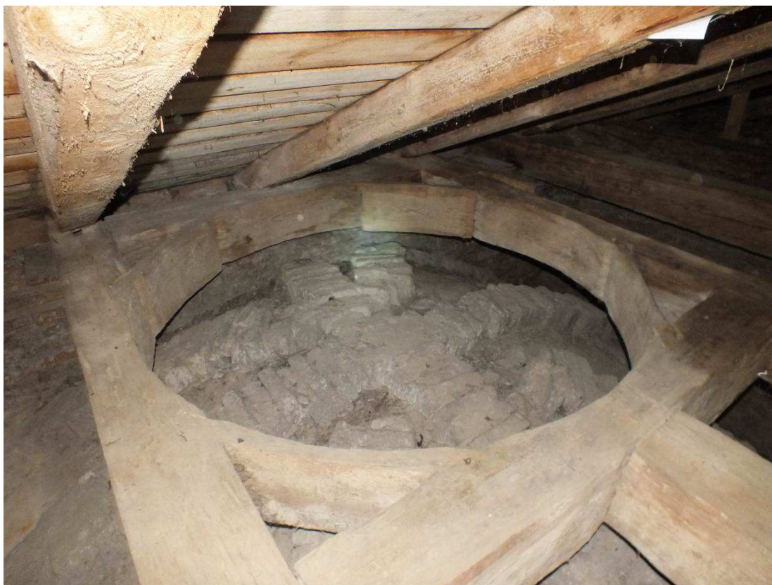
Fot.26 Wymiany w tramach wokół kopuły ceglanej.
