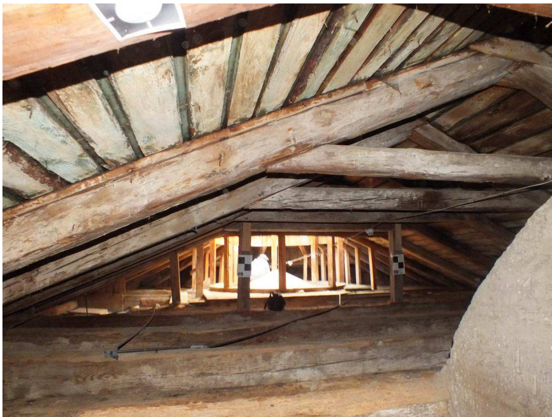
Fot.28 Widok na fragment więźby dachowej.
