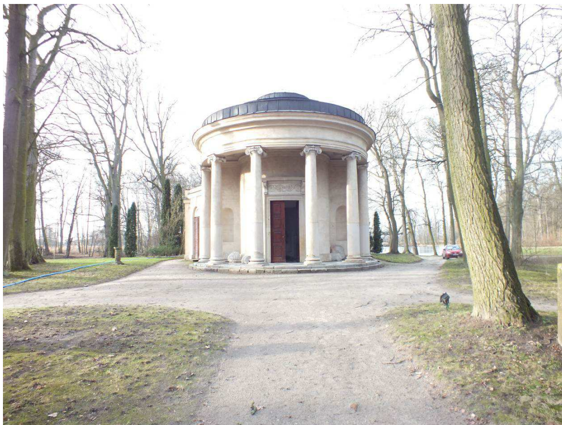
Fot.20 Elewacja południowo - zachodnia.
