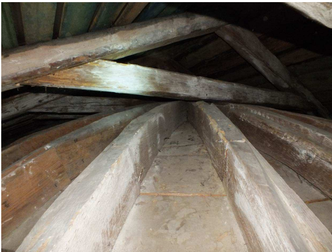
Fot.27 Widoczne oparcie jętki dachu na żebrach plafonu.
