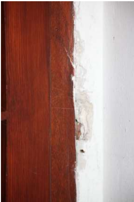
Fot. 108. Uszkodzenia przy ościeżach porte-fenetre'ów spowodowane prawdopodobnie wadliwym osadzeniem futryn i zawiasów zewnętrznych skrzydeł.
