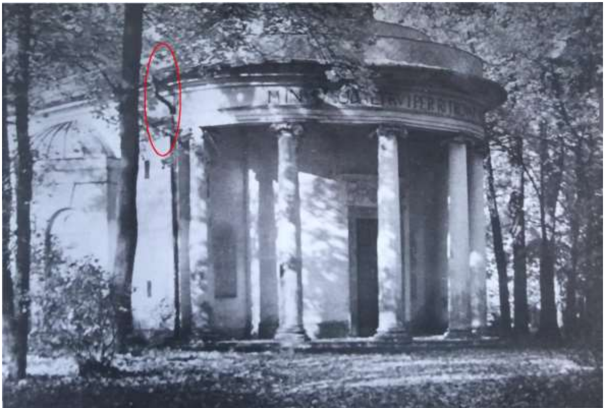
Fot. 21. Przed 1939 (fot. 1962_1965_Foto_MNA_108_3); Obwodowe orywnowanie i rury spustowe na zewnątrz, widoczny napis na fryzie
