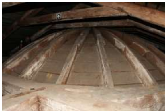
Fot. 45. Odkrywka w tynku na Plafonie Jutrzenka: widoczny stelaż trzciniowy mocowany do podbitki.
