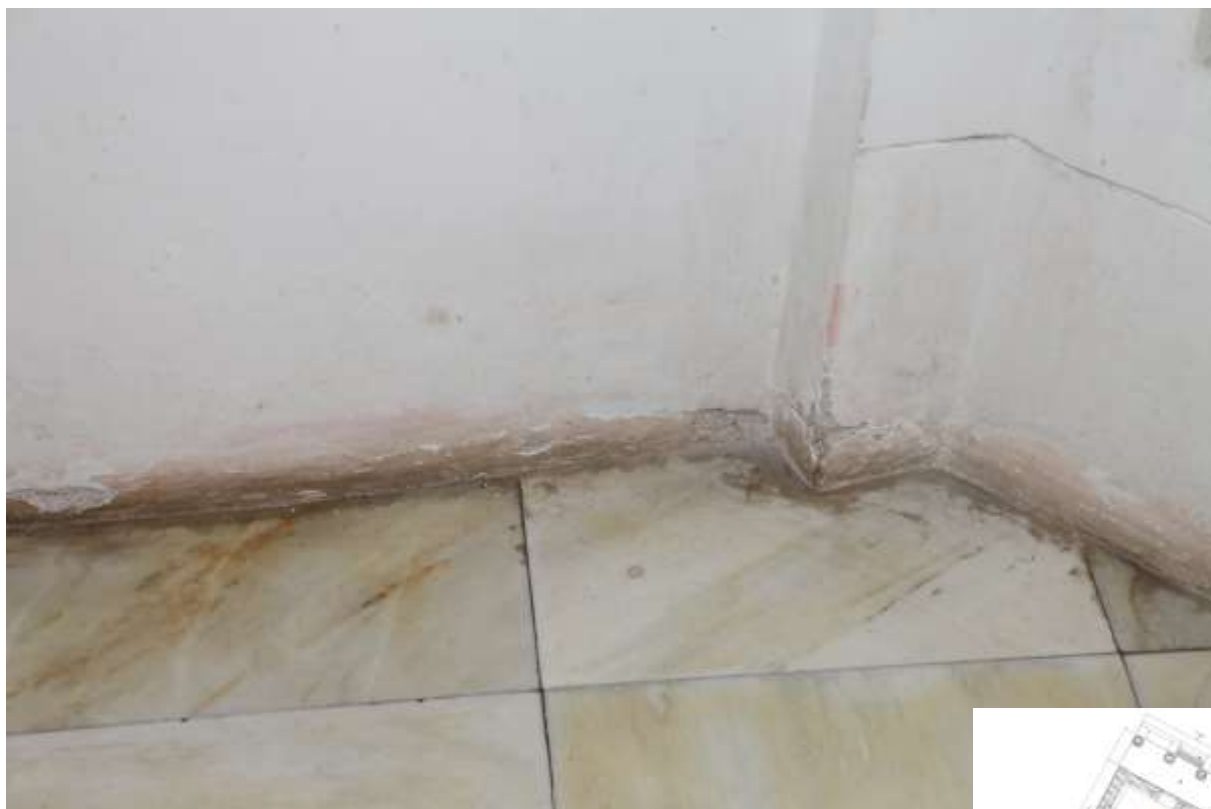
Fot. 120. Zawilgocenie wychodzące ponad posadzkę powoduje dezintegrację tynku.
