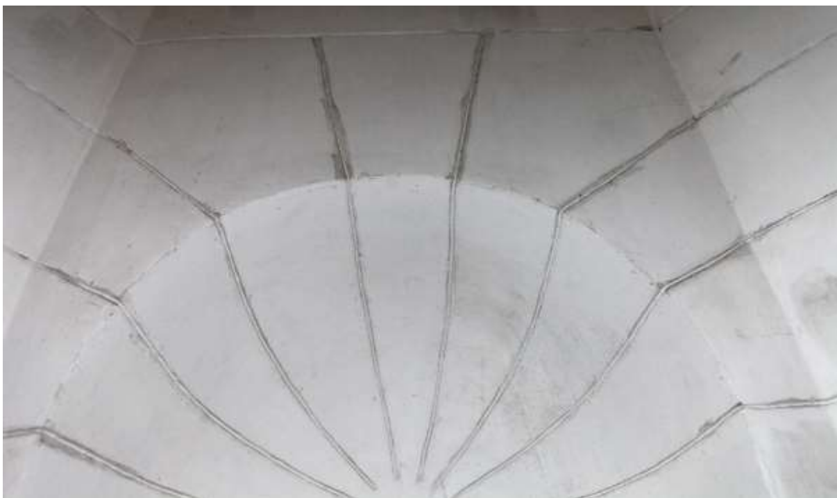
Fot. 122. Zabrudzenia i zmiany kolorystyczne . Retusze wykonane zapewne farbami akrylowymi poczerniały.
