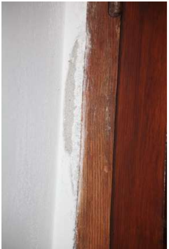
Fot. 108. Uszkodzenia przy ościeżach porte-fenetre'ów spowodowane prawdopodobnie wadliwym osadzeniem futryn i zawiasów zewnętrznych skrzydeł.
