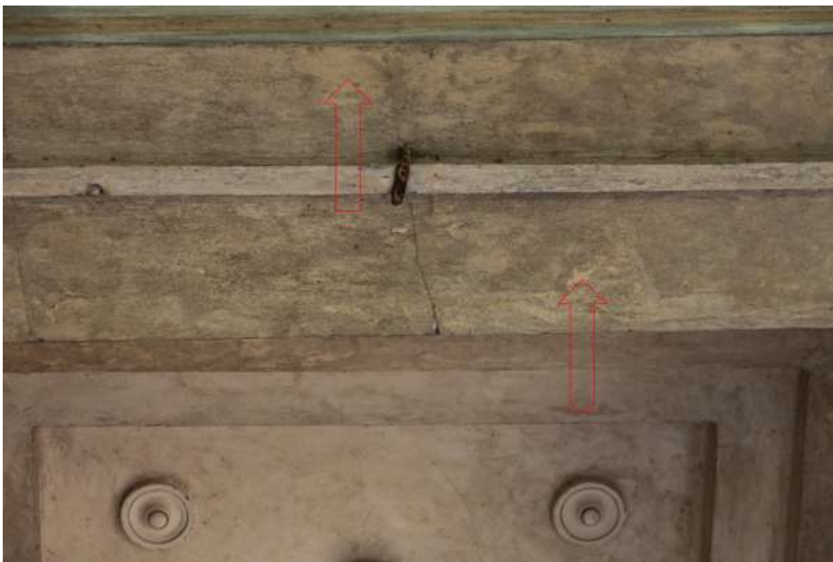
Fot. 59. Strona W – portyk, kasetonowe sklepienie; pod PKZ-etowską, ziarnistą przecierką widoczne starsze opracowanie powierzchni – (gładka warstwa ugrowa)
