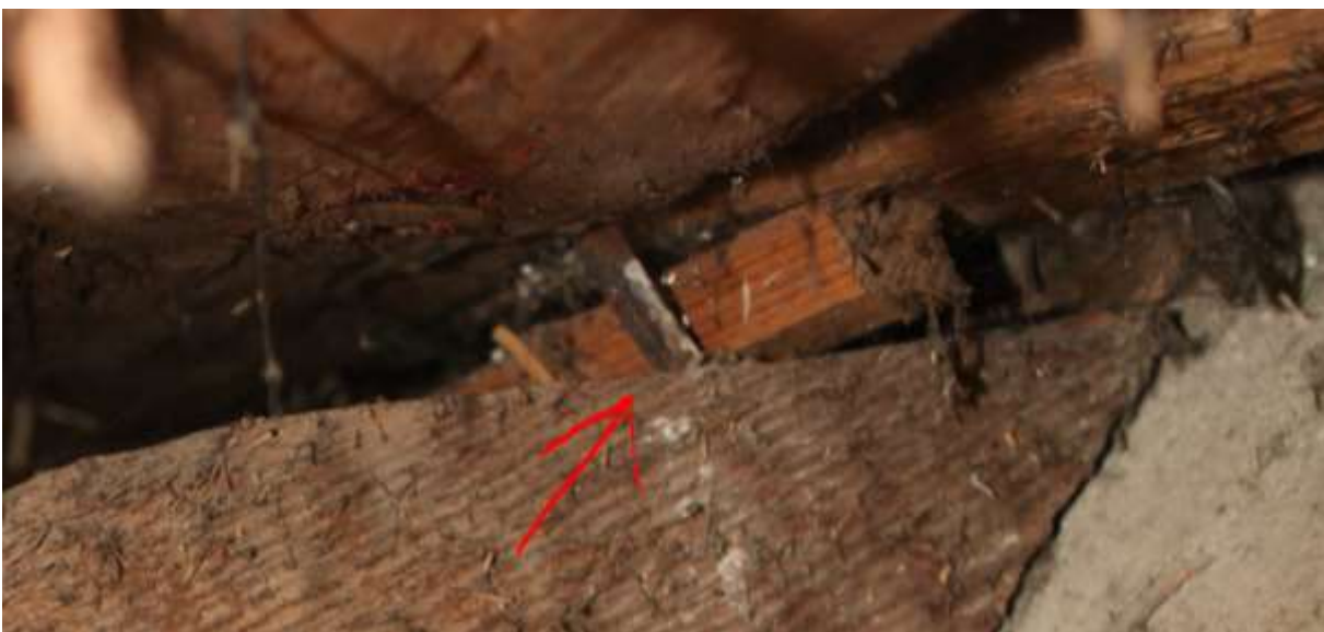
Fot. 48. Gwóźdź mocujący element krążyny do tramu.
