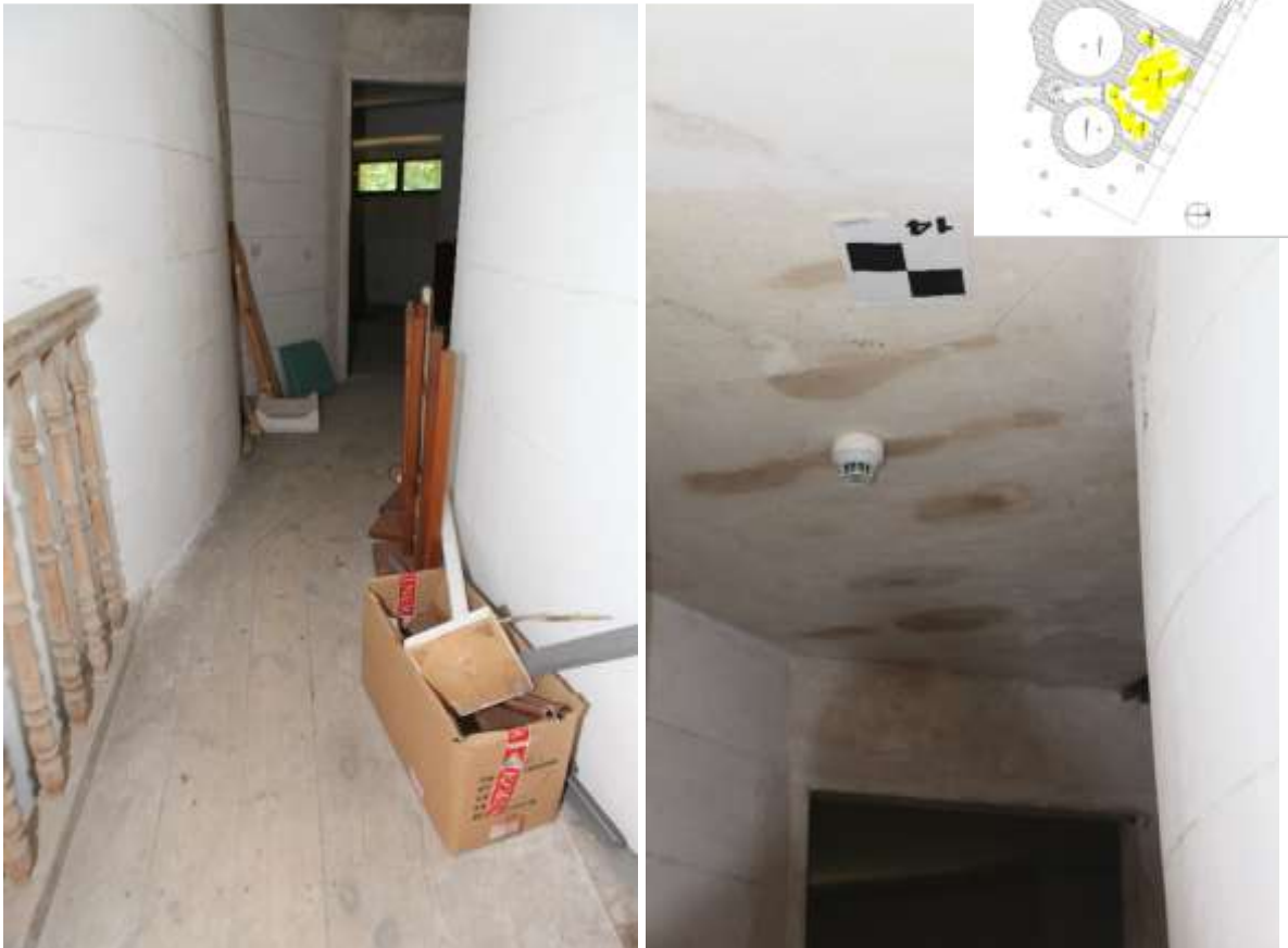
Fot. 128. Korytarzyk na poddaszu. Drewniana balustrada i podłoga.
