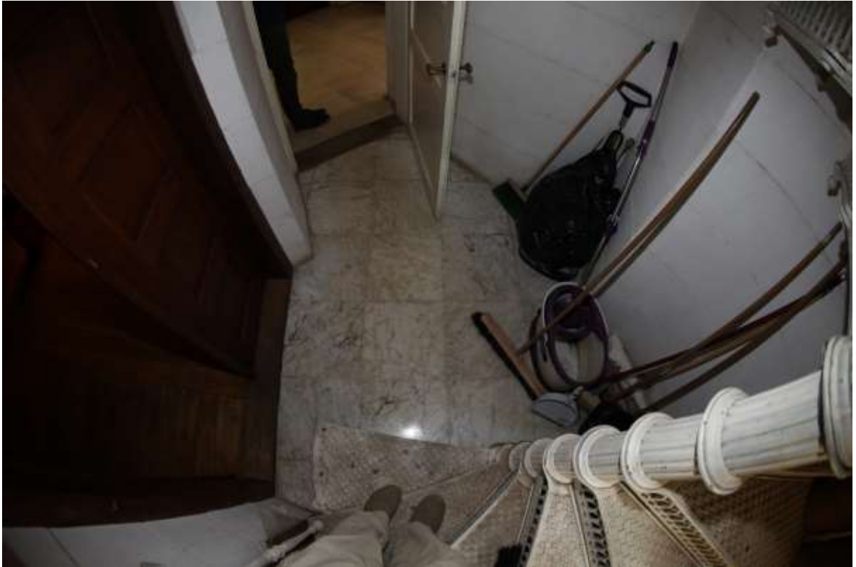
Fot. 126. Widok na posadzkę w klatce schodowej Przestrzeń ta powinna być ekspozycyjna. Podręczna przestrzeń gospodarcza powinna znaleźć się w pomieszczeniu nr 4 (służbówka)
