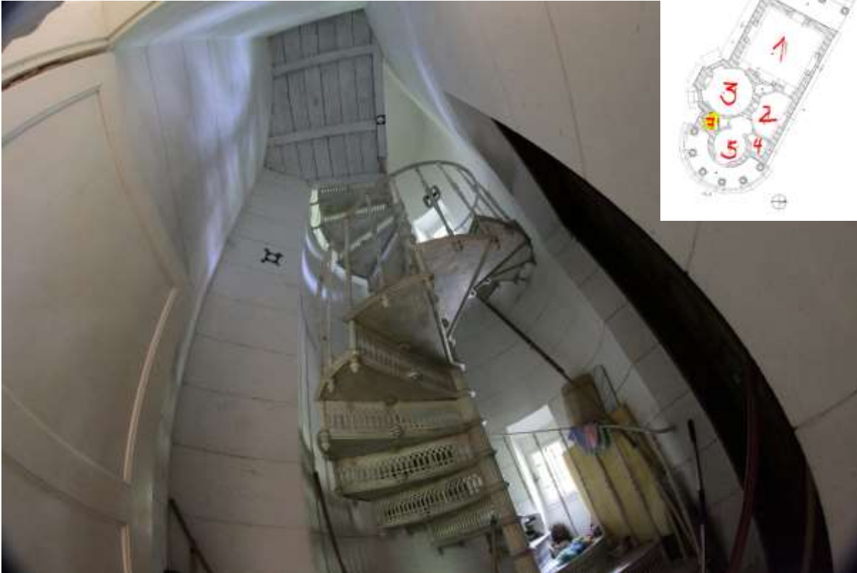
Fot. 124. Schody żeliwne. W dobrym stanie.
