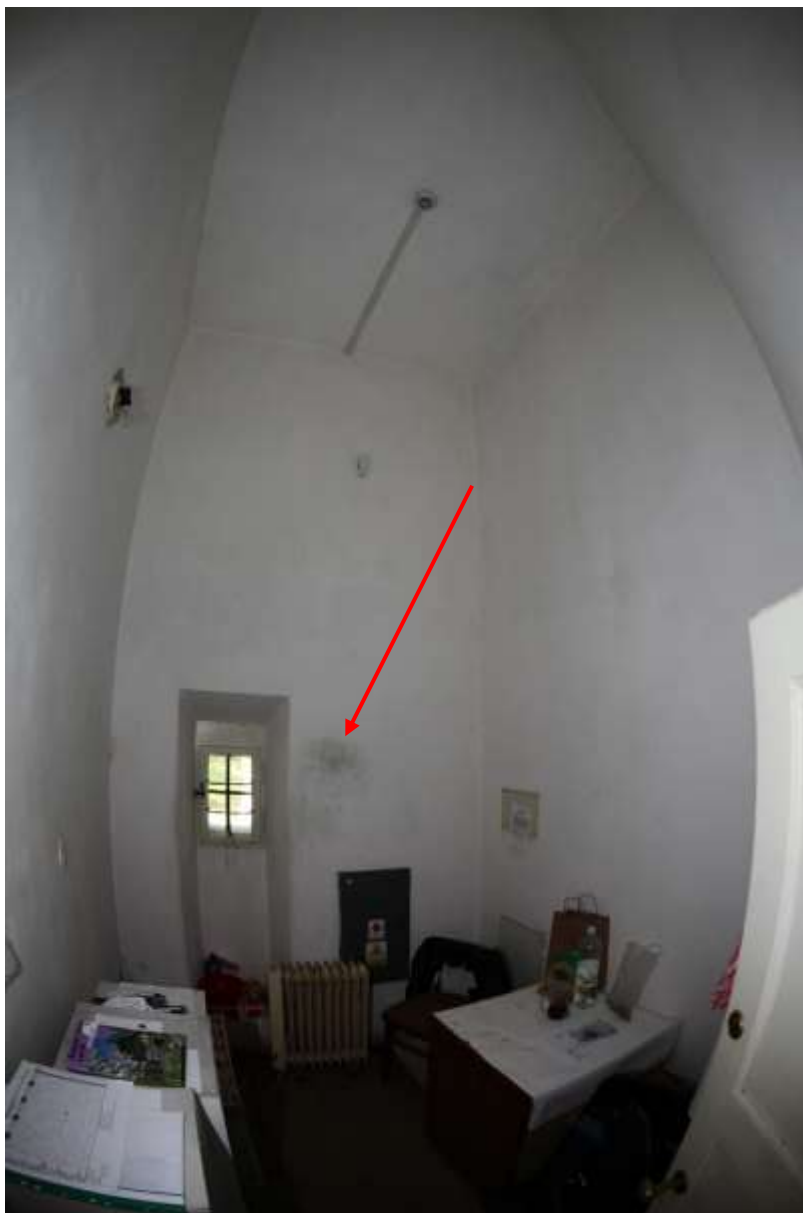
Fot. 110. Służbówka. Pomieszczenie zawilgocone. Naloty pleśniowe na ścianie ptn.
