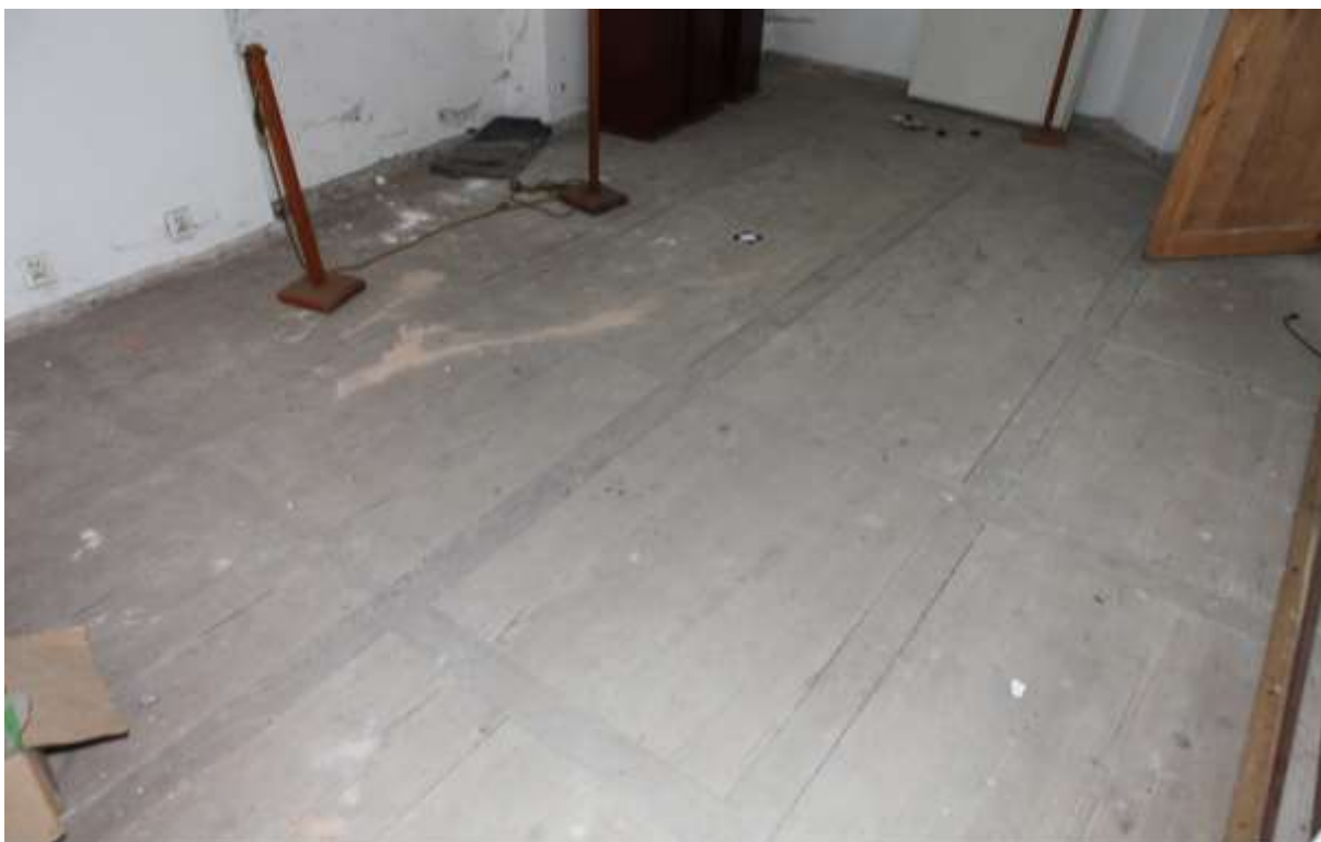
Fot. 132. Podłoga w pokoju na poddaszu zaniedbana. Uwagę zwraca artykulacja materiału : dębowe legary i szerokie sosnowe deski
