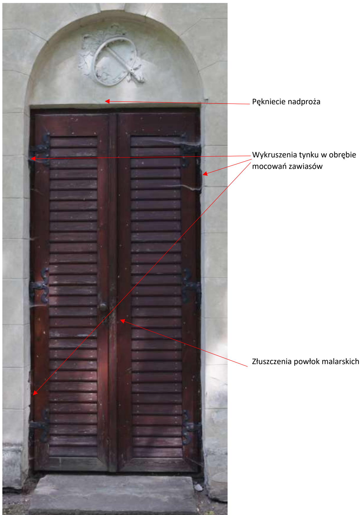
Fot. 78. Portfenetre do Sypialni Owalnej -skrzydła zewnętrzne.
