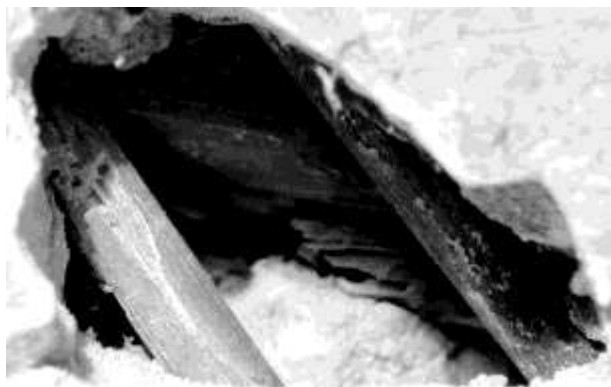
Fot. 45. Odkrywka w tynku na Plafonie Jutrzenka: widoczny stelaż trzciniowy mocowany do podbitki.
