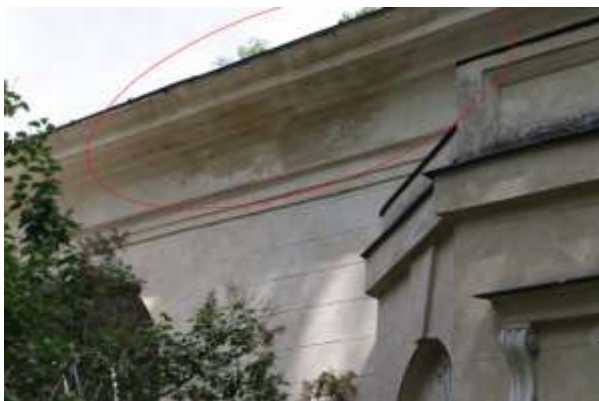
Fot. 30. Strona S; lejowaty zaciek na gzymsie i ścianie - lokalne uszkodzenie lub brak drożności systemu rynien.
