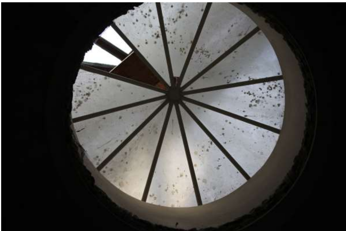
Fot. 33. Naświetle od wewnątrz.
