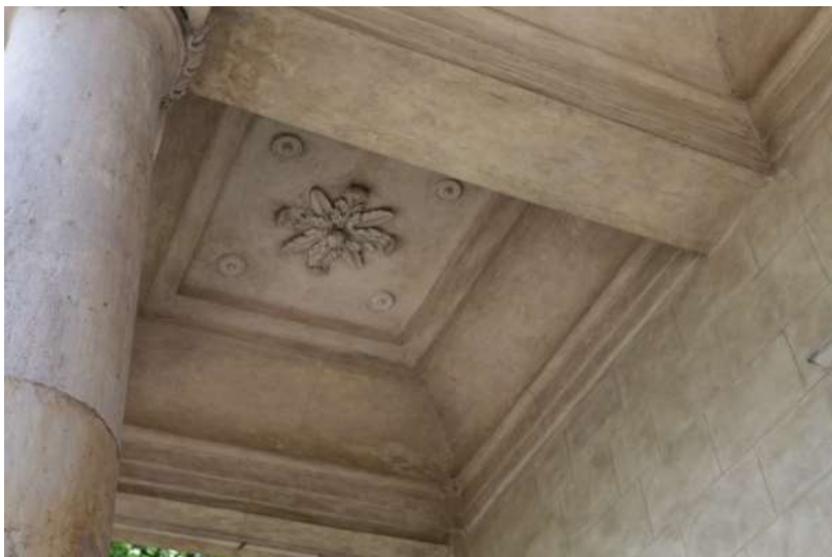
Fot. 58. Strona W – portyk; kasetonowe sklepienie; pod PKZ-etowską przecierką widoczne starsze opracowanie powierzchni – (warstwa ugrowa).
