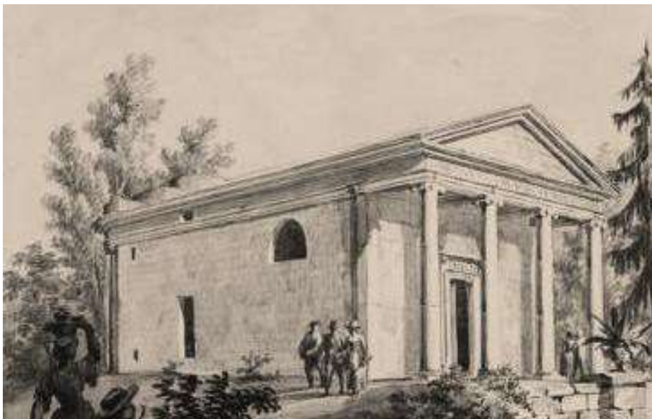
Fot. 25. Porównanie 1783-2016. Podczas remontu w latach 60. przywrócono pierwotny układ bez rynny obwodowej (wykonano rynny pogrążone), a rury spustowe przeprowadzono na wskroś gzymsu.
