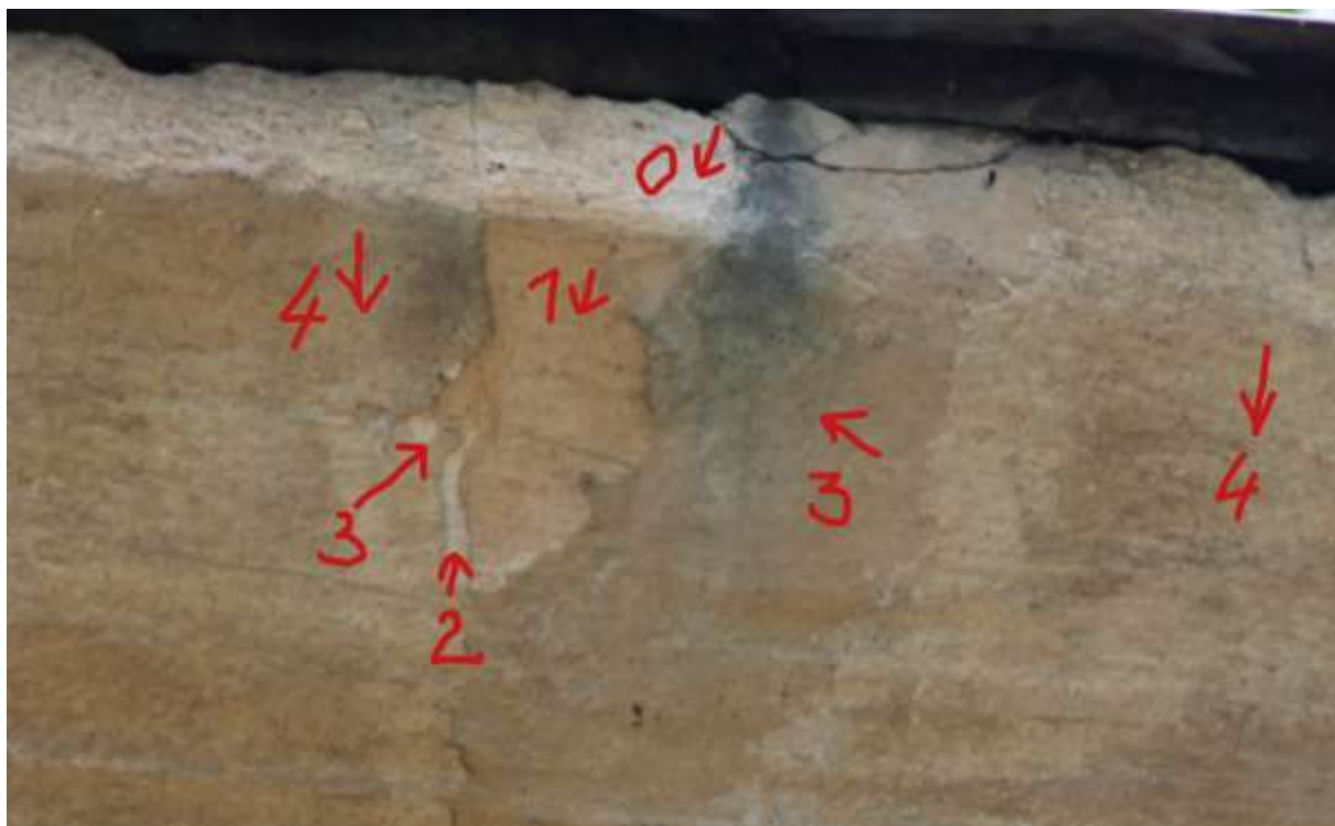
Fot. 61. Strona N – gzyms; w ubytku widac uwarstwienie wypraw – na białym rdzeniu (0) pomalowanym na kolor piaskowy (1) widoczne kolejne warstwy : biały podkład (2), spoista i gładka wyprawa piaskowa (3) i kolejna warstwa złożona z jasnego, ziarnistego podkłady i wykończenia w kolorze piaskowym (4).
