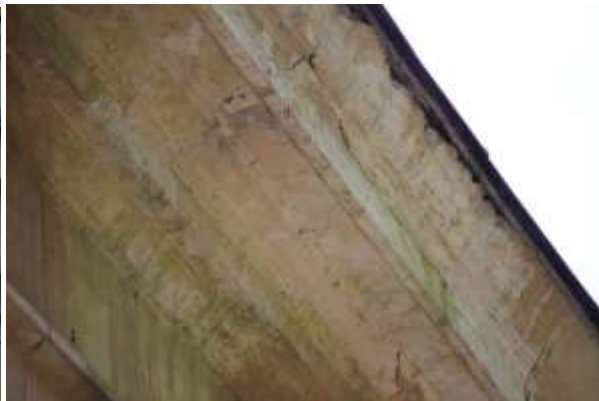
Fot. 30. Strona S; lejowaty zaciek na gzymsie i ścianie - lokalne uszkodzenie lub brak drożności systemu rynien.
