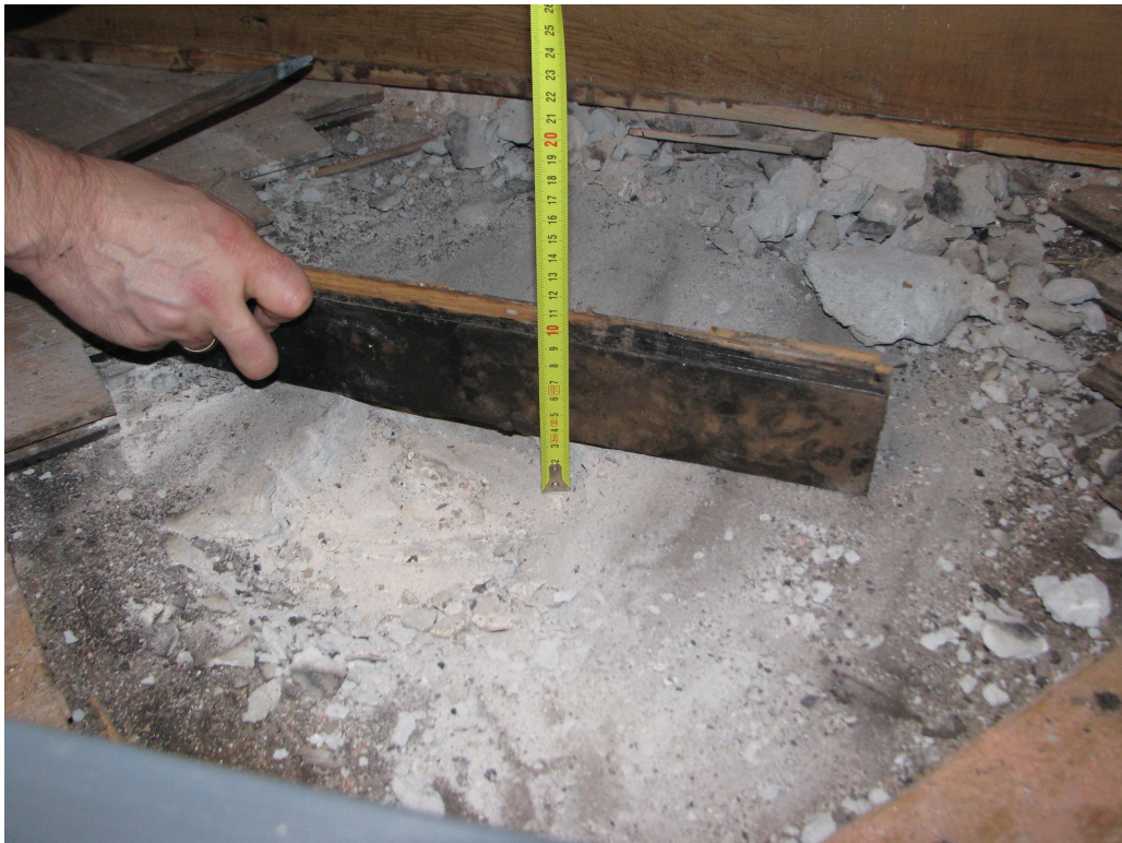
Rysunek 1: Odkrywka warstw posadzkowych
