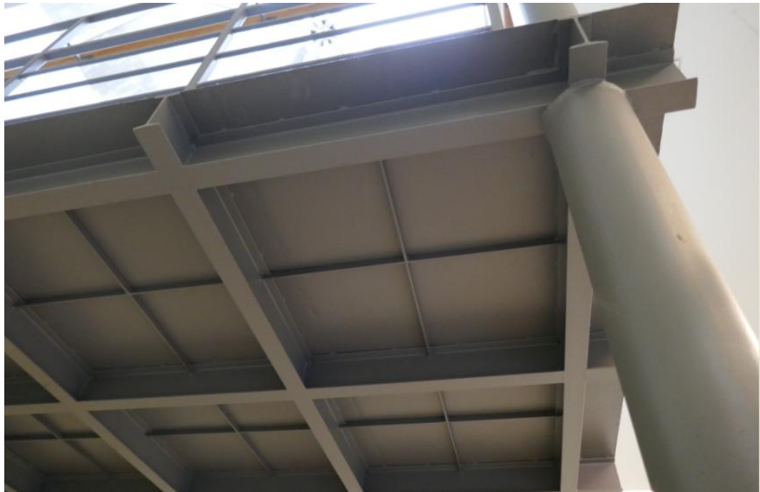
Widok głowicy słupa i układ belek pomostowych wraz z widokiem żeber usztywniających blachę żeberkową.
