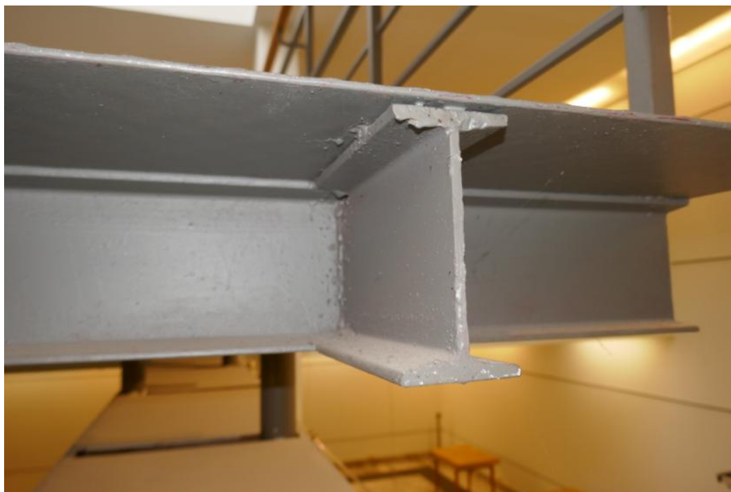
Widok profilu pomostu ( dwuteownik I 140).
